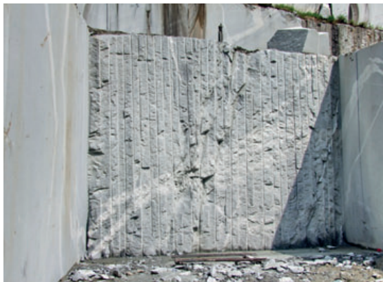
V delu etaže je bil blok odstranjen tako, da so plast vzporedno navrtali in nato odstrelili. Sedaj pretežno nove bloke pridobivajo z žaganjem (foto: Marjan Šenica, 1. 5. 2011).
