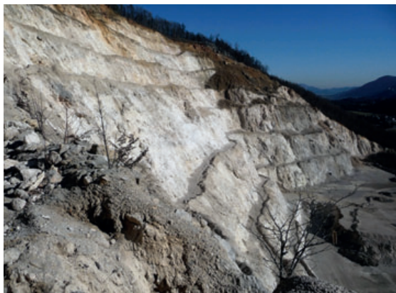
Pogled na etaže kamnoloma s skrajnega zahodnega dela, pri čemer je vidno, da se na policah hitro nabira grušč iz tektonsko zelo zdrobljenega triasnega dolomita (slika 2, foto: Franc Golob, 7. 2. 2011).
